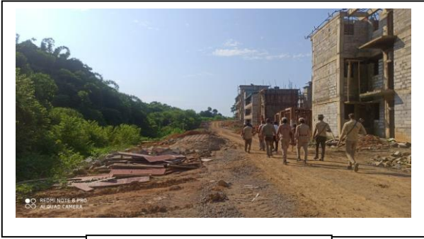
Hawalder Barrack site
